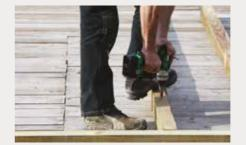
← Fixer mécaniquement une ossature bois (chevrons de 8 x 6 minimum ou double tasseau) dans la structure bois existante et au travers de la volige, y compris en périphérie pour assurer l'étanchéité à l'air de la toiture.
